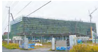
▲建設中のデータセンター
