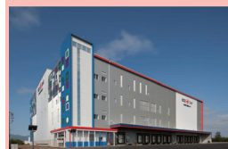
平成26年4月に増設された石狩第二物流センター※横浜冷凍(株)より提供
