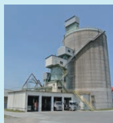
容量18,000トンのサイロで、社会インフラ整備に欠かせないセメントを供給している。
