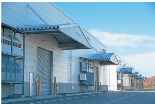
1,000㎡に仕切られた低温倉庫が計18倉あり、全体の収容能力は約5万トンを誇る。
