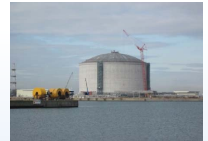
石狩LNG受入基地建設状況
