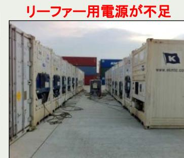
【図 自家発電による電源確保状況】
